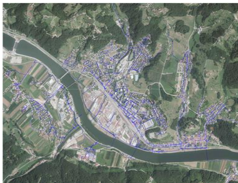
Kanalizacija Sevnica, Boštanj, Log
