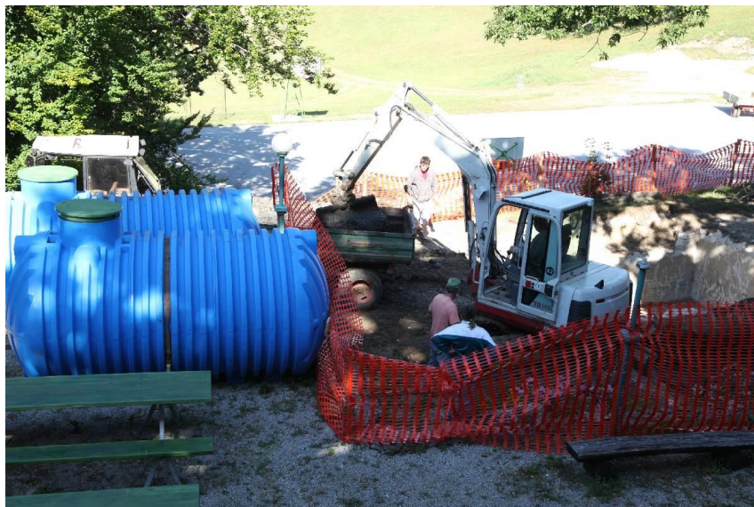
Praznjenje greznice ob izgradnji rastlinske čistilne naprave
