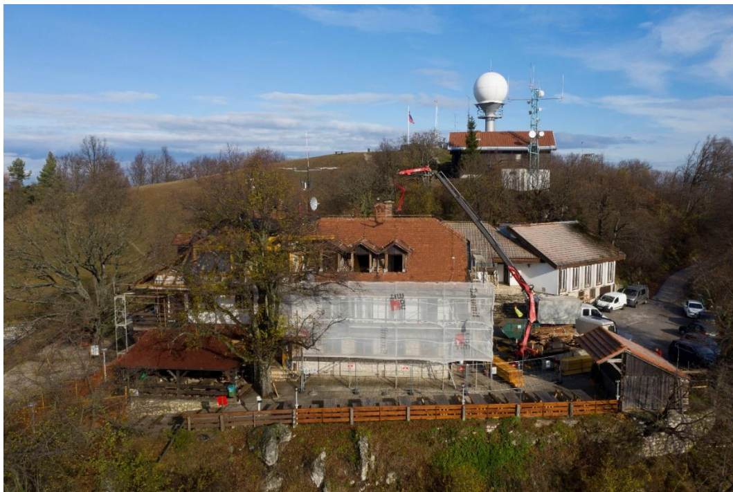
Obnova strehe Tončkovega doma
