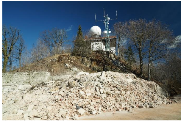
Rušitev depandans je potekala v začetku leta 2020
